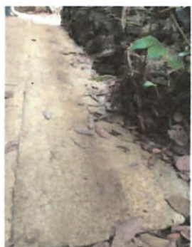
Foto 3: Reparación de canales de concreto para conducción superficial de agua pluvial, con pendiente y refuerzo.
