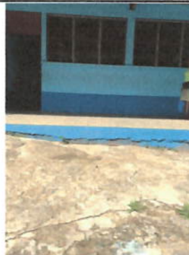
Foto 2: Reparación de losa de concreto para patios, considerando preparación de terreno, armado, nivelación y acabado rustico.
