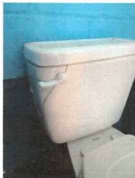
Foto1: Sustitución de sanitarios lavables, accesorios y conexiones.
