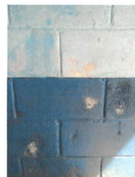
Foto 4: Reparación de repello y cernido en muro de mampostería con aplicación de acabado uniforme
